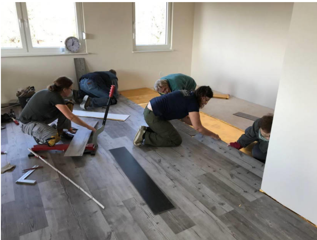
Bereits am Wochenende 16./17.2 wurde mit dem Fußboden begonnen und die beiden Umkleieräume fertig gemacht. Am 23./24.2. war das Team so eingespielt das der Clubraum, Flur, WC und Abstellraum fertig wurden! Tolle Leistung!
