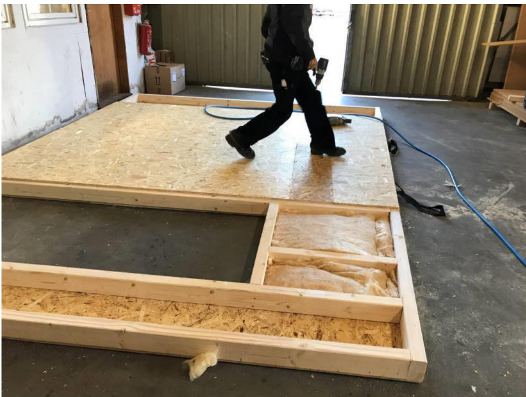
Am 11.12.2018 entsteht die letzter Innenwand, innen Schallisolierung, beide Seiten mit 15 mm OSB-Platten versteift.
