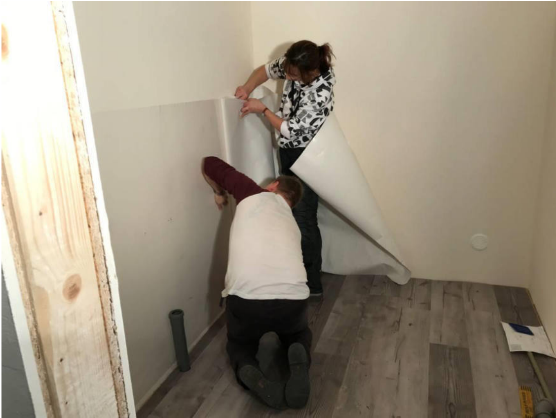
Im Sanitärraum werden die Wände mit Elefantenhaut wasserfest gemacht.
