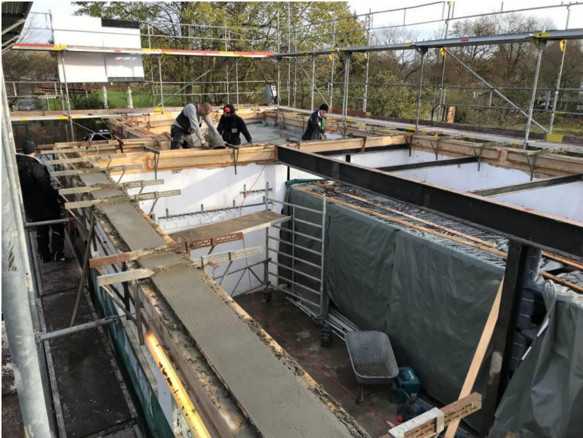
30.11.2018: Der Ringanker ist fast fertig und soll nun die nächsten Tage trocknen.
