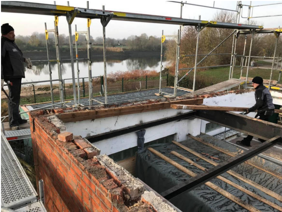
Der letzte Balken wird entfernt.
