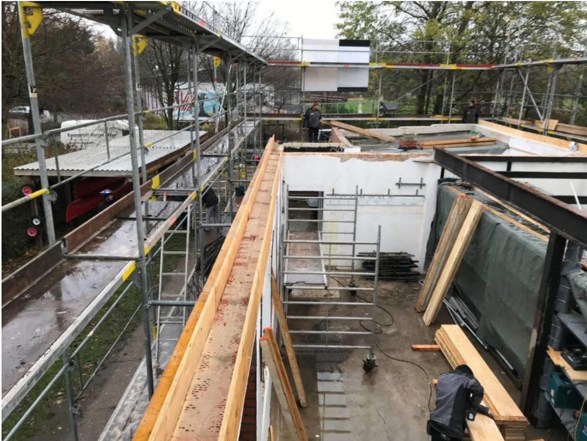
29.11.2018: Für den Ringanker wird die Verschalung angebracht.
