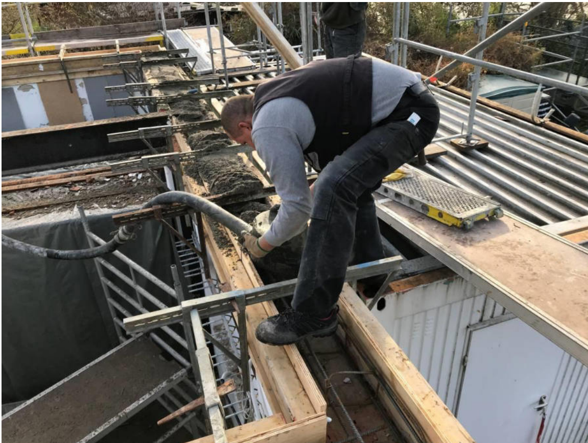
30.11.2018: Das Bett wird mit Baustahlgeflecht stabilisiert und dann mit Beton gefüllt.
