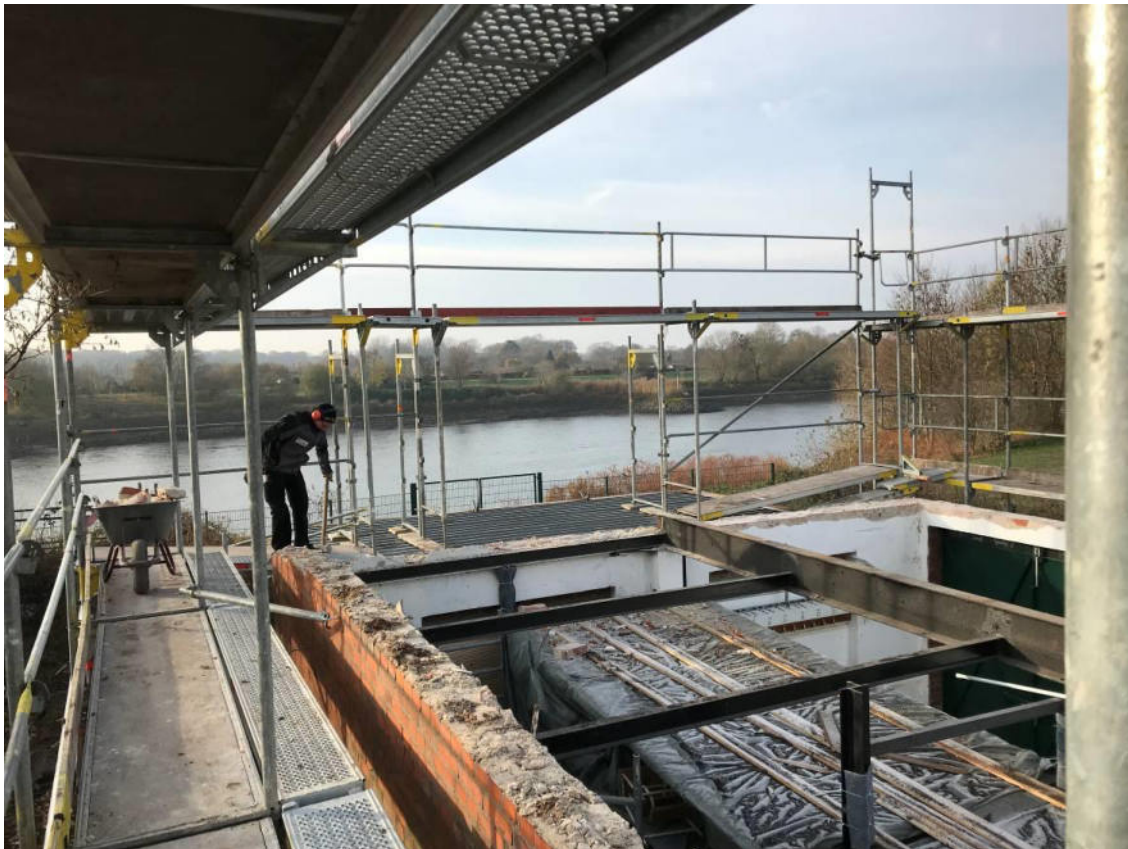
Der obere Teil des Mauerwerkes wird entfernt.
