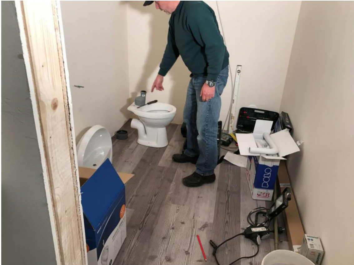
Am 16.03.2019 wurde mit dem Sanitärbereich begonnen.
