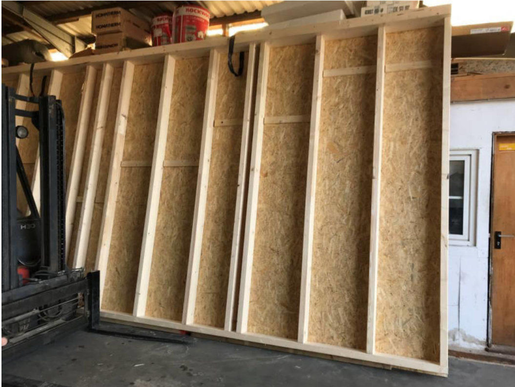
Herstellen der Rückwand, auf der Innenseite 15 mm OSB-Platte.
